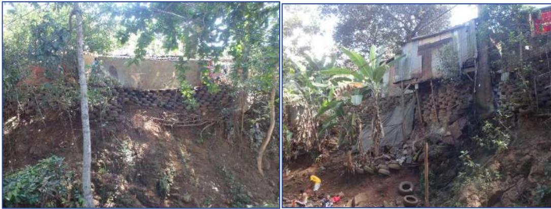
Figure 54 : Talus stabilisé au moyen de pneus.
