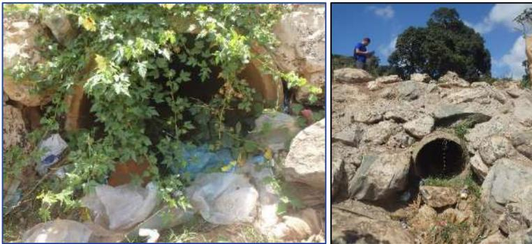
Figure 58 : Ouvrage busé partiellement comblé permettant la transparence hydraulique
