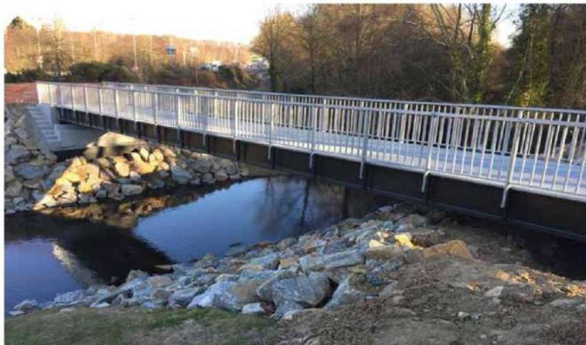
Figure 32 : Exemple de passerelle de type quadri-poutres (Passerelle de Gesvres (44-Nantes))
