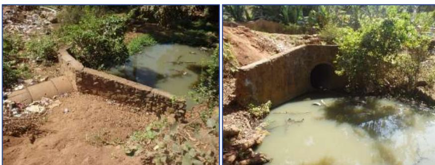
Figure 55 : Ouvrage busé dégradé sous l'action des submersions successives
